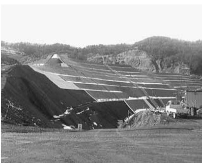
最終処分場対策工事
